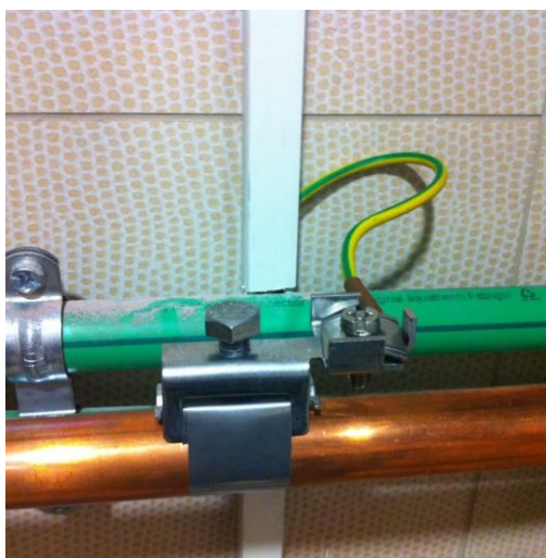
obejmy opaskowe założone na rury z przyłączonymi przewodami uziemiającymi
