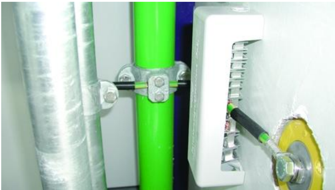
obejma uziemiająca rurę - sposób wykonania połączeń
